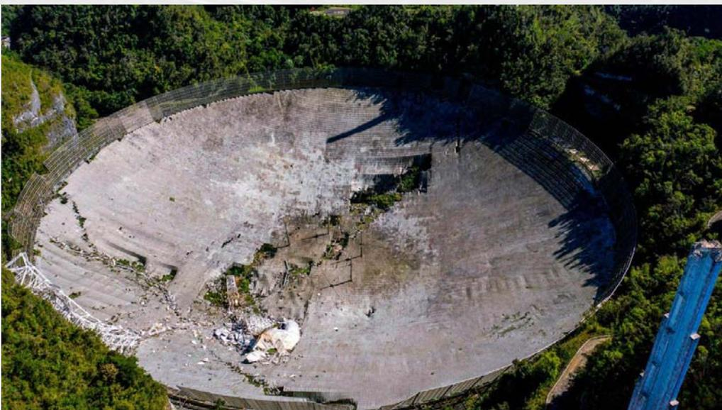
圖3. 2020年12月1日，阿雷西博天文臺的巨大天線被上方的接收器平臺砸毀。懸掛於上方的接收器平臺重達約900公噸，因為支撐平臺的纜繩斷裂而墜落。(Credit: RICARDO ARDUENGO /AFP via Getty Images)
