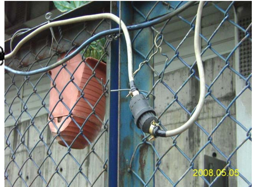
三相電動機器電纜用接頭
