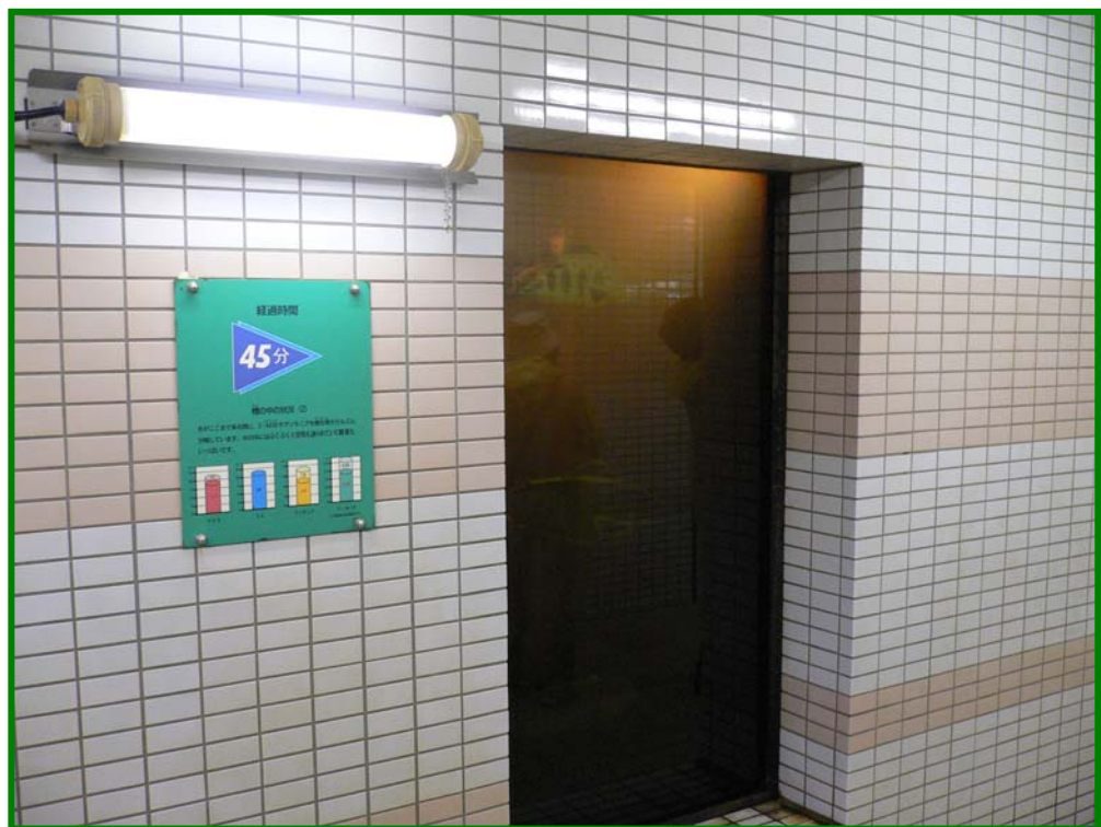
圖 4.2 地下廊道設有視窗可供觀察礫層
