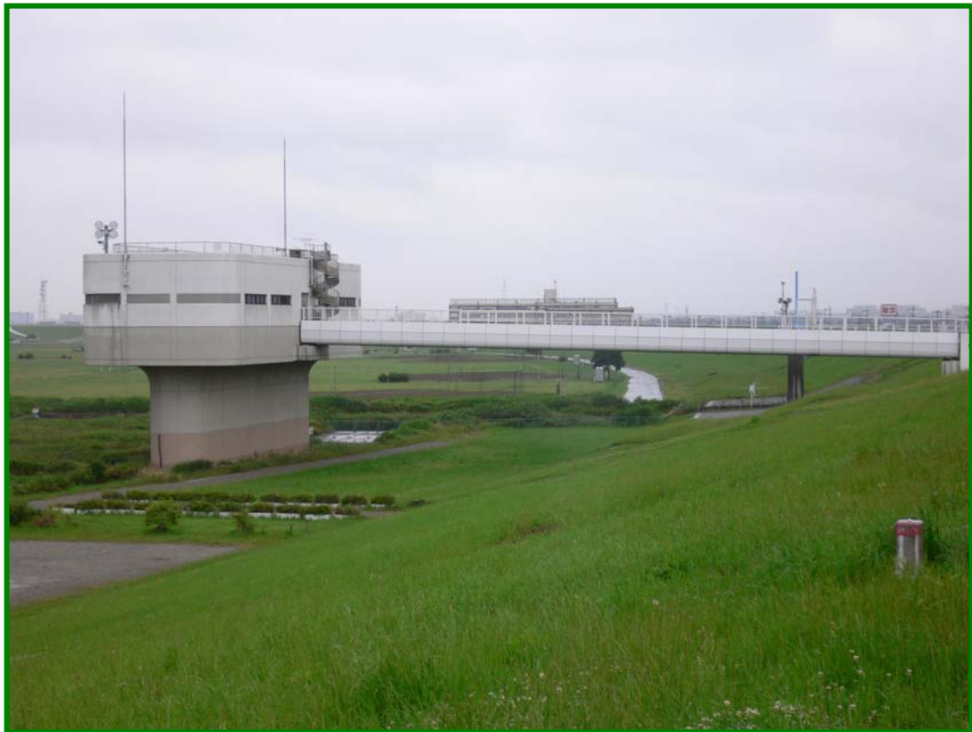
古崎礫間接觸淨化設施操作塔
