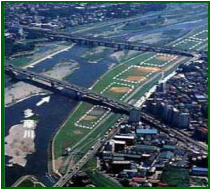
平瀬川礫間接觸淨化槽位置
