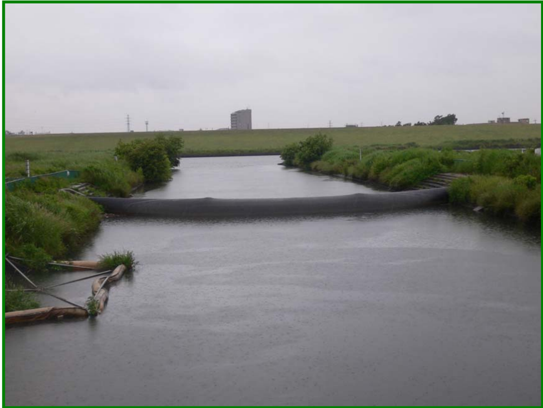
古崎礫間接觸淨化設施橡皮壩及入流口
