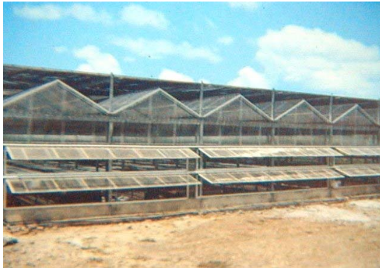
圖 10.24 機械式強力通風的方式，此側為進氣口
