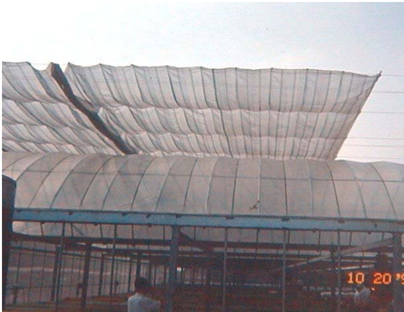
圖 10.22 台灣地屬亞熱帶，容易產生熱累積，故許多溫室必須採用外遮蔭
