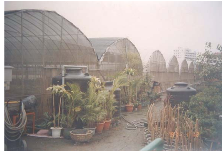
圖 10.4 膠布為透明材料建立之圓頂型溫室
