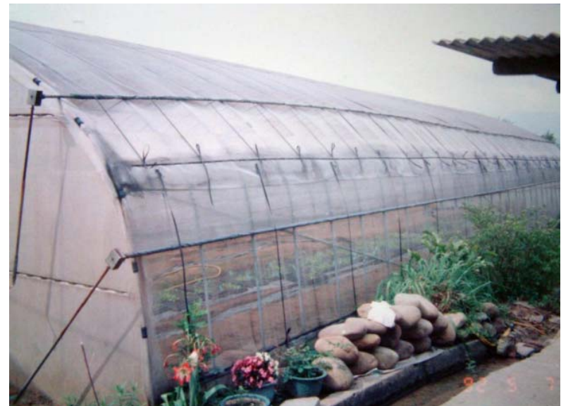
圖 10.20 塑膠佈溫室以隧道式為主，其上另有壓條固定
