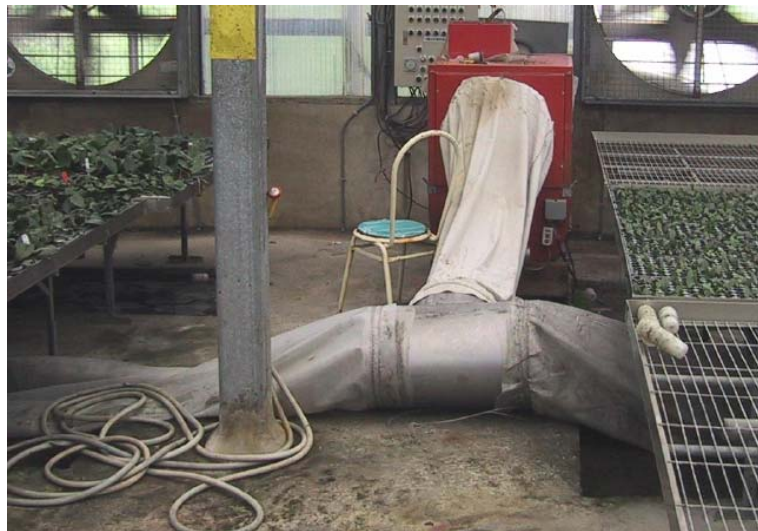
圖 10.30 地面加溫系統（豐南育苗場）
