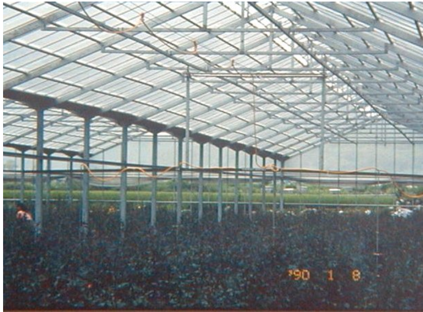
圖 10.21 玻璃纖維板為透明板可以拉大跨距，形成大結構
