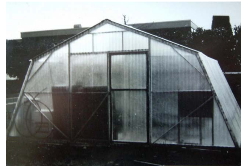
圖 10.5 玻璃纖維為透明材料，易裝卸之簡易型溫室
