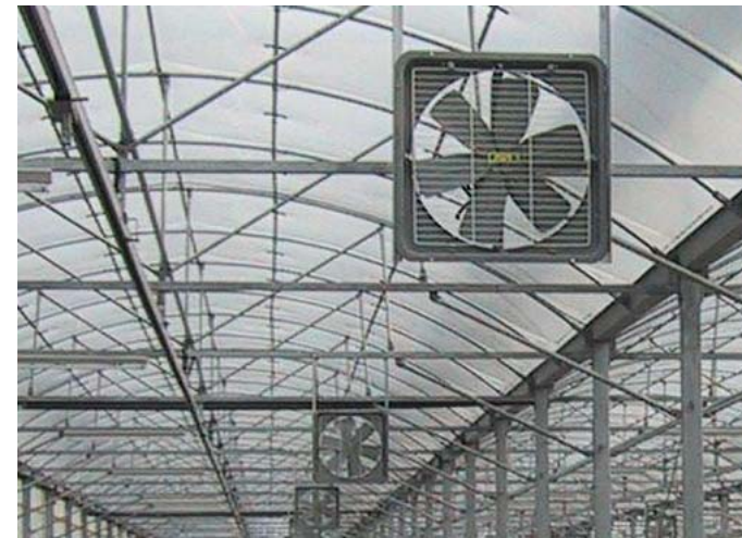
圖 10.23 攪拌式通風，將風機設於溫室之正中央，強迫使空氣產生對流作用
