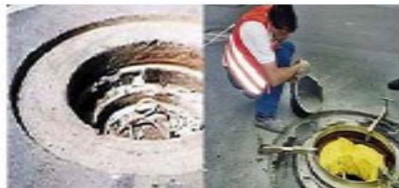
圖 2-12 調整高低差並澆置填充材料
