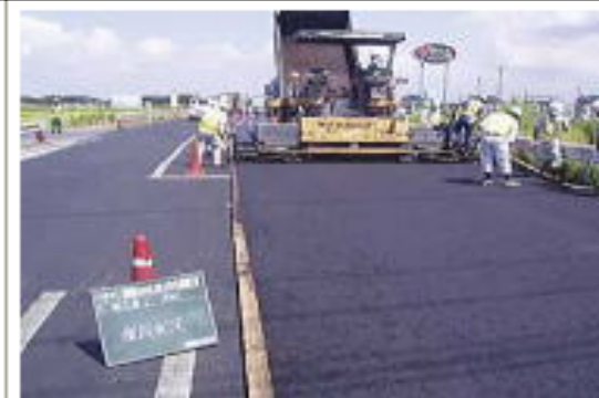
因為連續施工可確保鋪設品質平順均一
