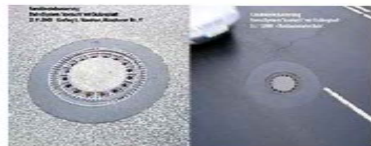
圖 2-14 置換新舊人孔蓋後開放通車
