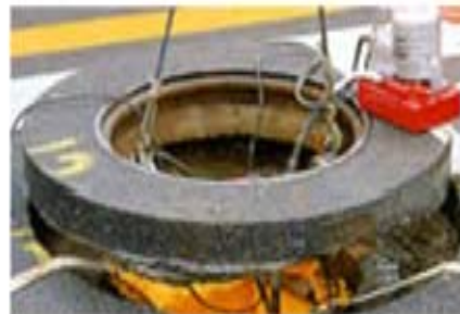
將外框吊起撤除
