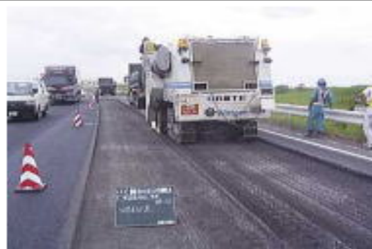
因人手孔已下降，刨除機可直接連續施工
