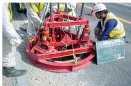
將鐵蓋拿下後裝上遮斷盤
