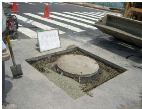
孔蓋提昇施工
