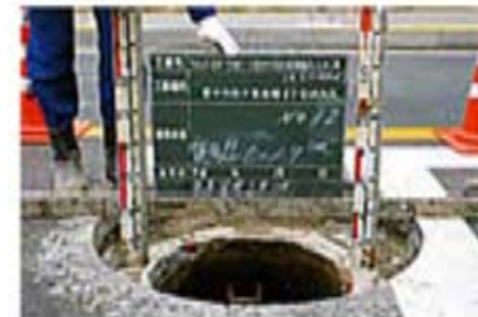
吊除後確認高程
