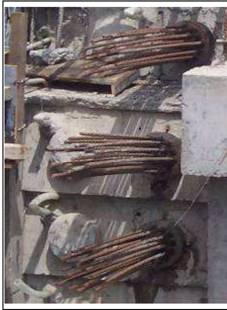
圖 2-17 鋼腱端錨設置(研究人員自行拍攝)
