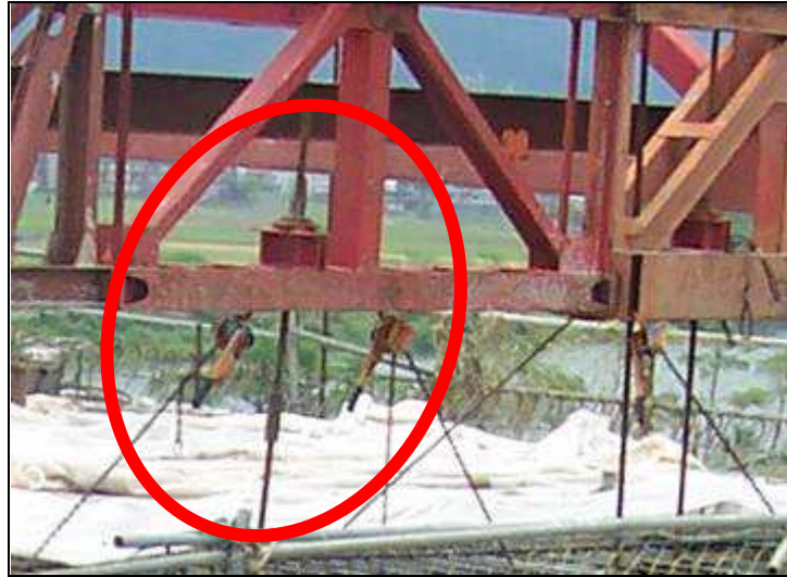
圖 2-6 懸吊系統(吊桿、吊架及鍊式起重器)
