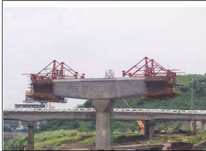
圖2-1平衡施工法(研究人員自行拍攝)
