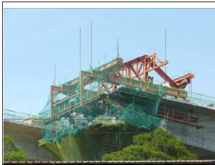
圖 2-5 主鋼架、前後桁架、水平支撐桿件
