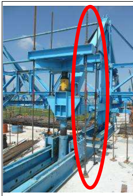
圖 2-12 固定主鋼架錨錠鋼棒(研究人員自行拍攝)
