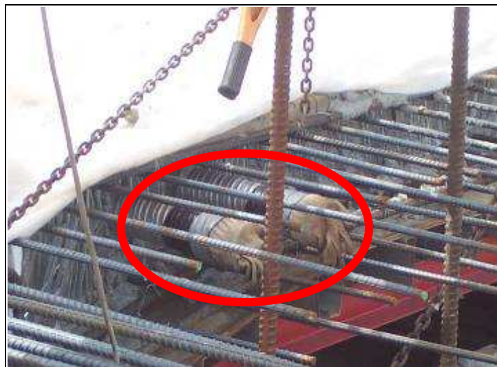
圖 2-15 鋼腱套管預埋(研究人員自行拍攝)
