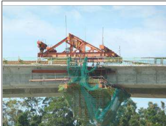
圖 2-21 以工作車施作閉合節塊(研究人員自行拍攝)
