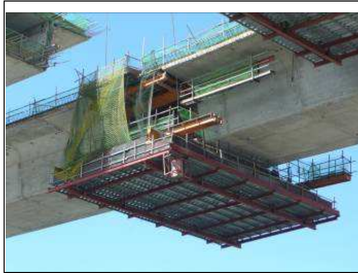
圖2-20中央閉合節塊連結(研究人員自行拍攝)
