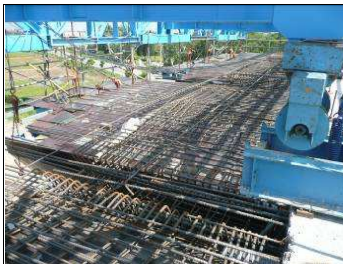
圖 2-14 頂版鋼筋綁紮(研究人員自行拍攝)
