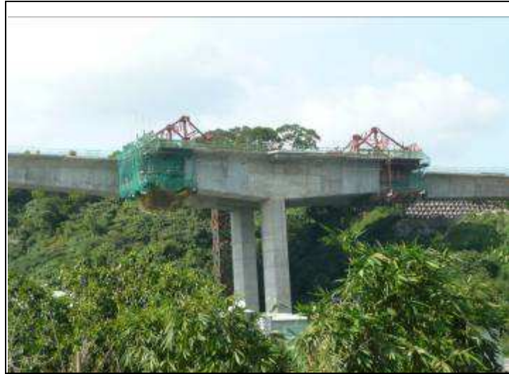
圖2-2不平衡施工法(研究人員自行拍攝)
