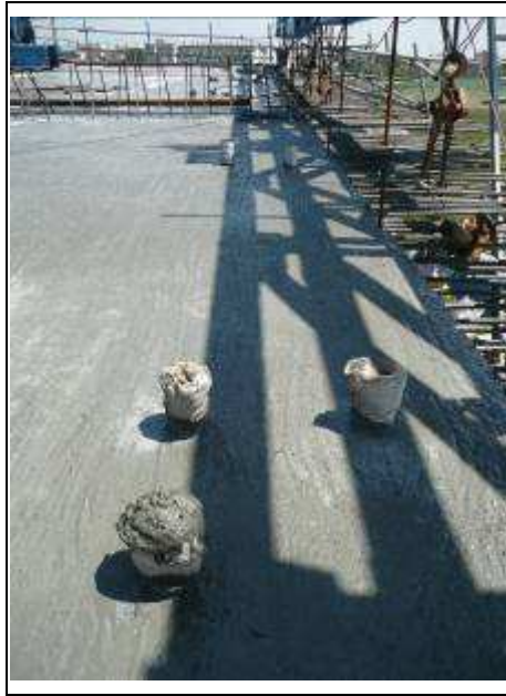
圖 2-16 錨錠鋼棒預留孔埋設(研究人員自行拍攝)
