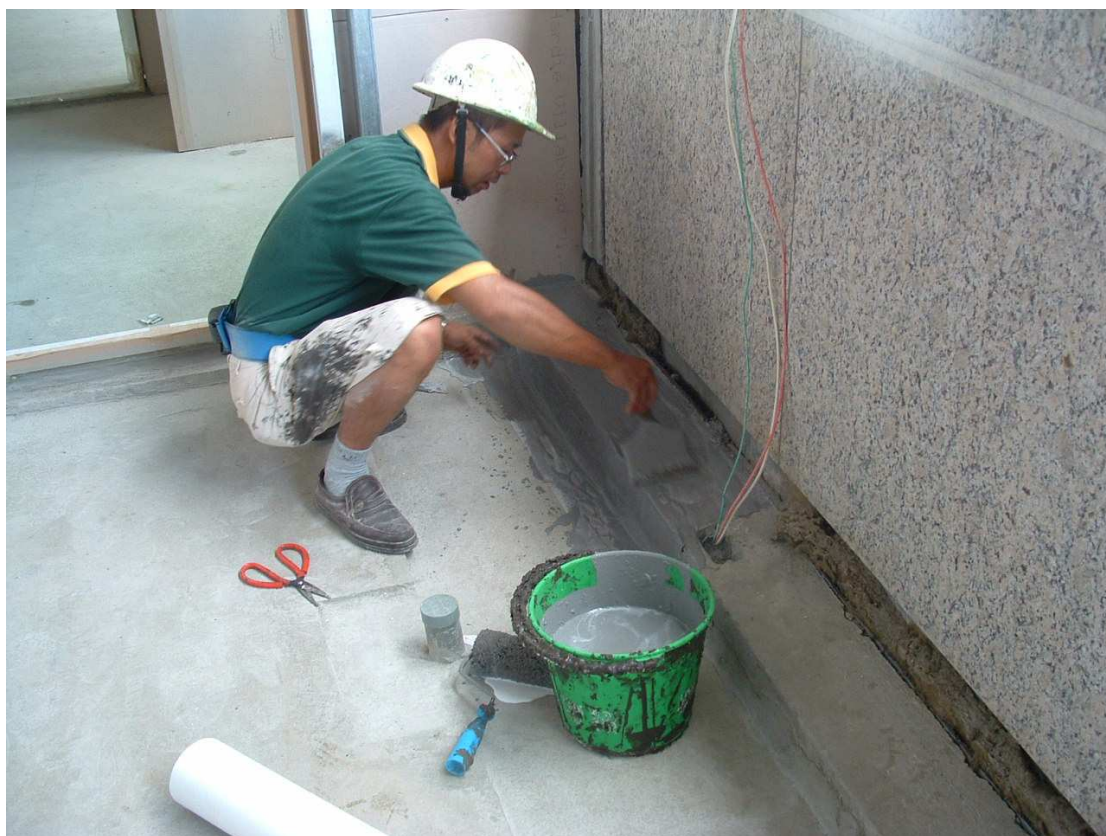
圖片二 塗膜系 PU 防水施工
