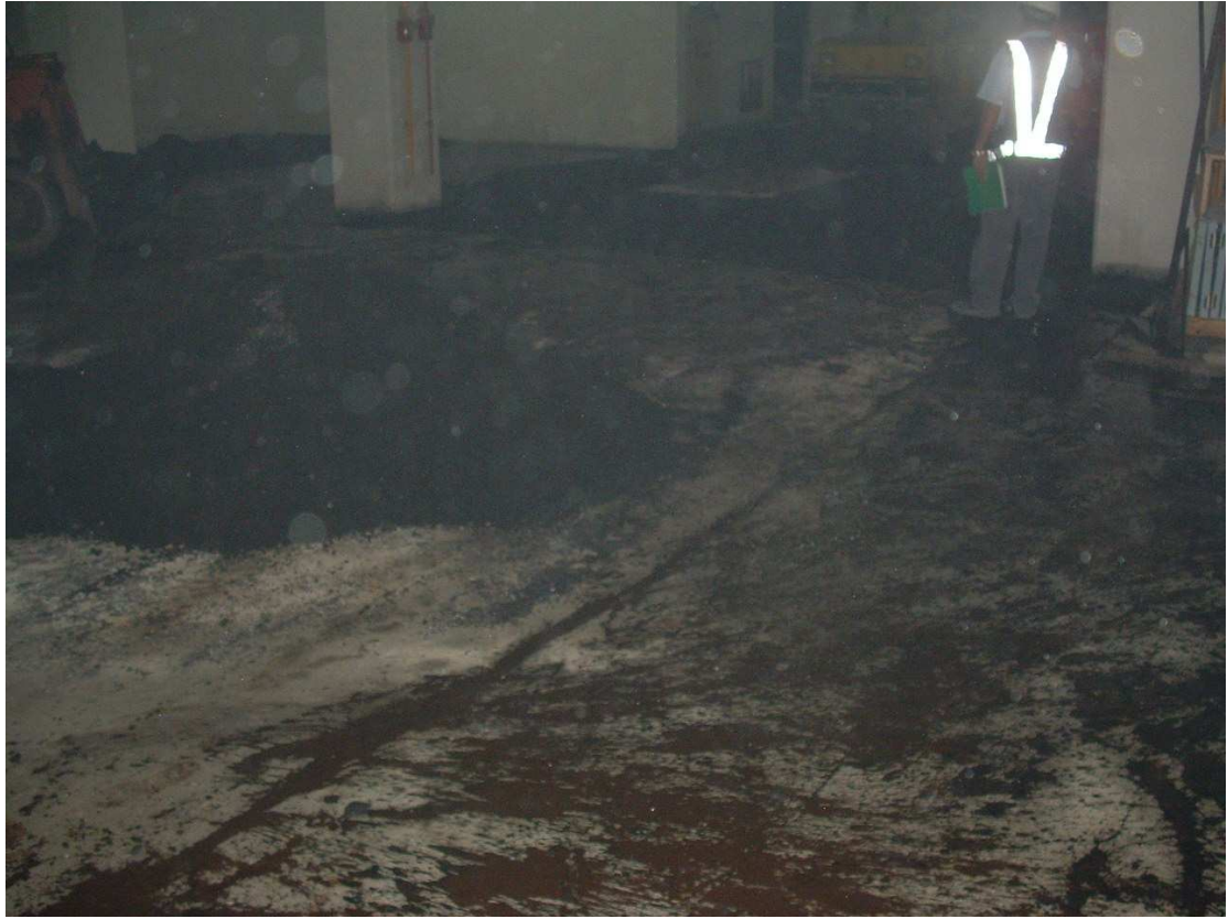
圖三 瀝青熱工法施工
