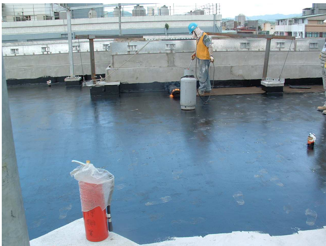
圖片一 烘烤系防水施工
