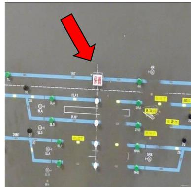
說明：該轉轍器係由控制室操作運轉，雖標準程序規定清潔時不得運轉並設警告標誌，惟當日站務佐理進行清潔時，轉轍器仍在運轉，導致手指夾傷災害發生。
