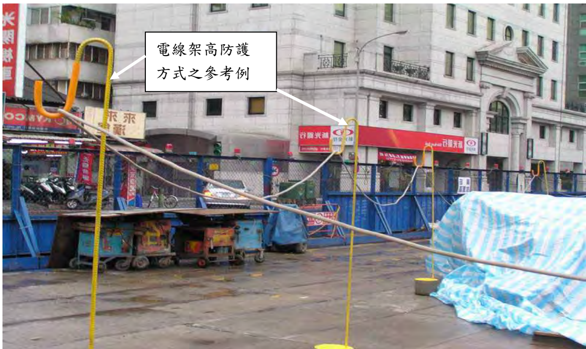
照片 8 電線架高防護參考例
