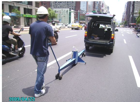
忠孝東路道路平整度量測
