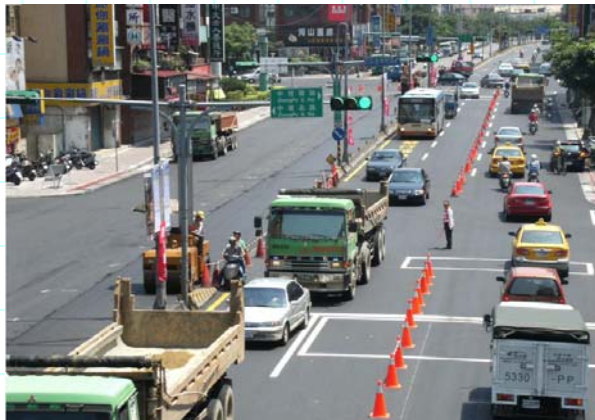
忠孝東路施工情形
