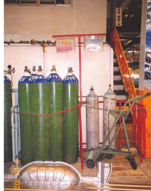
高壓氣體鋼瓶已依規定標明所裝氣體之品名且妥予固定。
