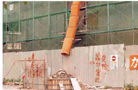
設置滑槽及承受設備。
