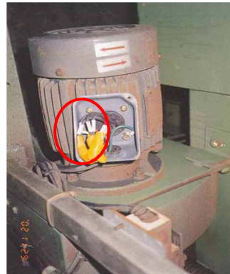
馬達外殼設置接地設備。
