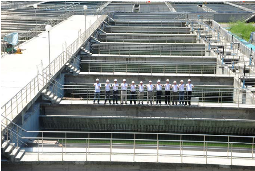
▲直潭淨水場第六座淨水處理設備工程
