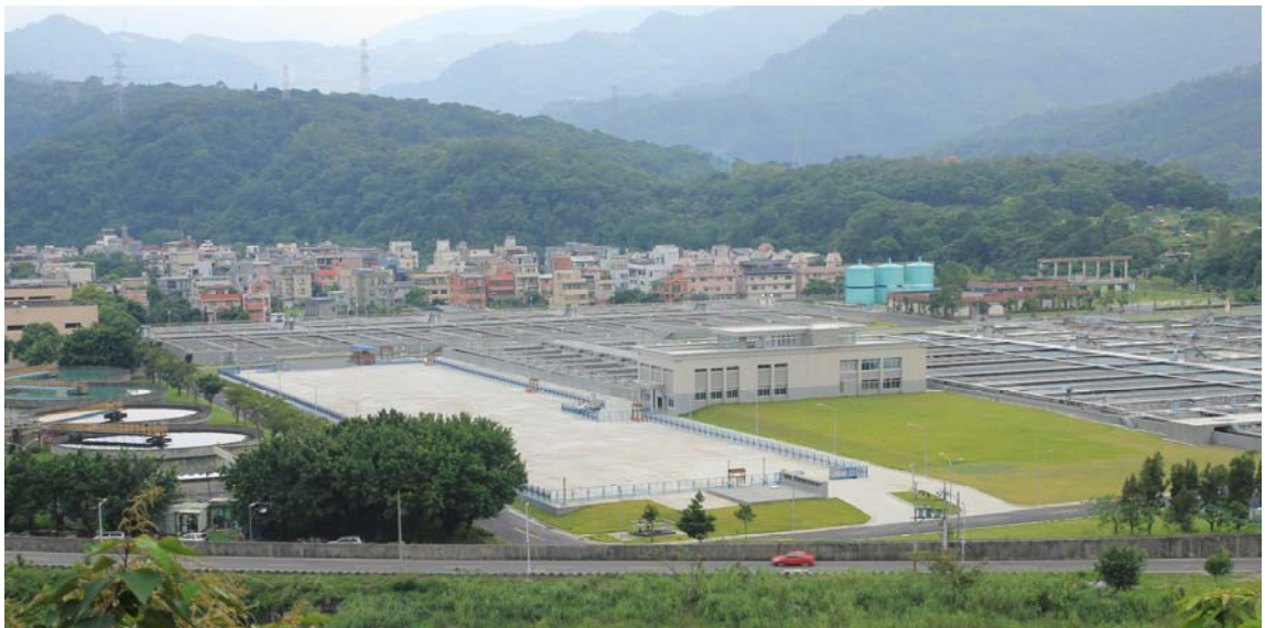
▲直潭淨水場第六座淨水處理設備工程
