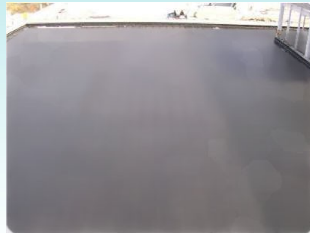
(10)鋪設抗根酸PE保護板
