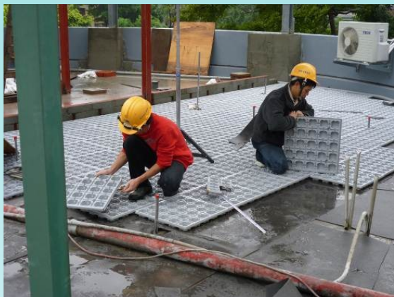
(1) 鋪設排導水板
