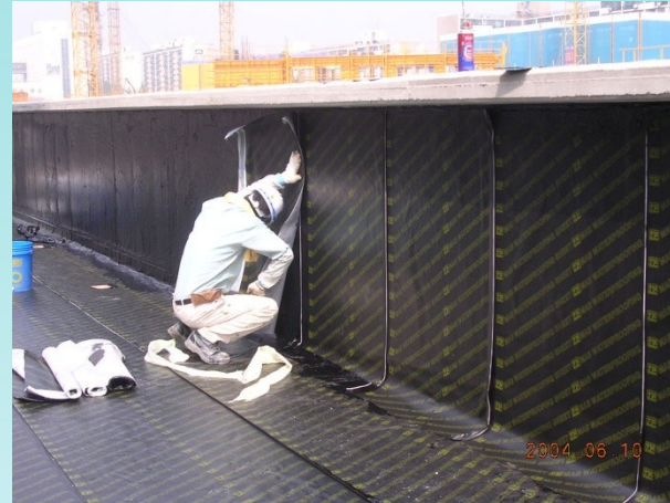
(8)垂直部位防水氈鋪貼
