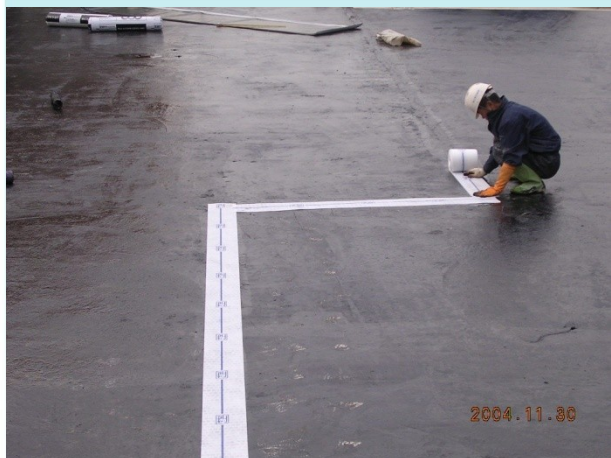
(4)施工縫或裂縫補強
