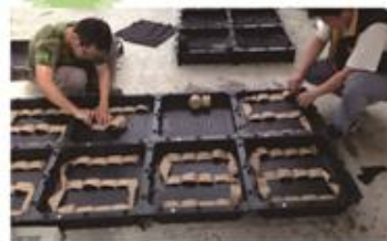
放置儲水箱及鋪設給水帶
