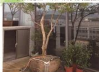
架設磐地式支架固定喬木
