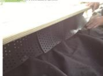
設置沖孔板阻隔植栽及介質
