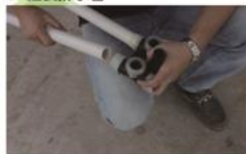
以旋轉方式將水管與三通連接頭旋緊
