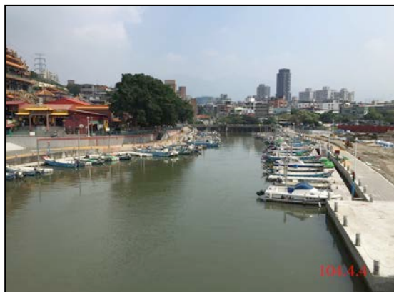
中港河碼頭及周邊環境改造工程
