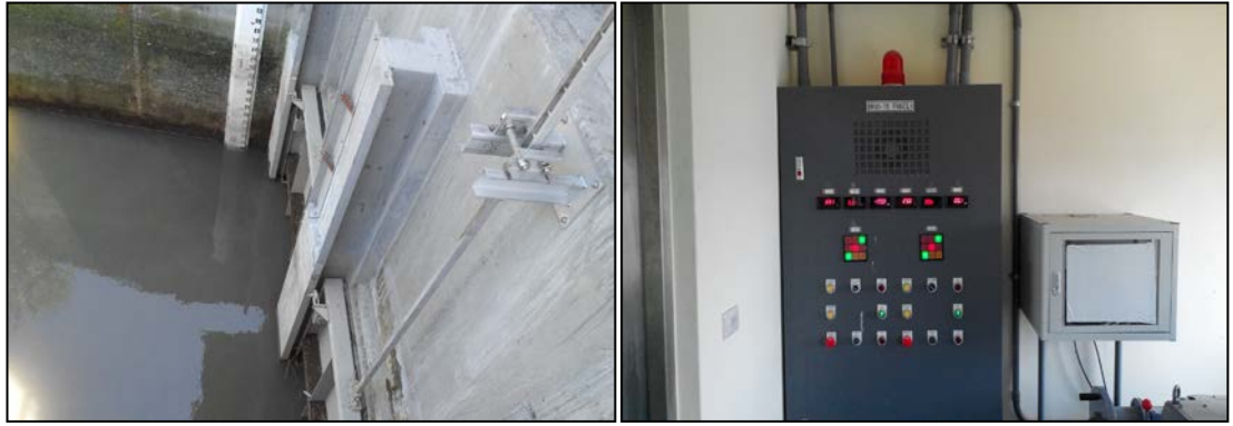
社子島地區及成美抽水站閘門及吊門機改善工程
