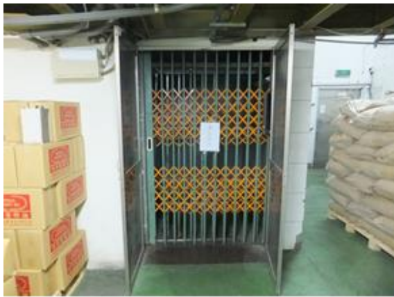
說明：發生職災之升降機採光照明不足 (乘場門外未裝設照明設備)。
