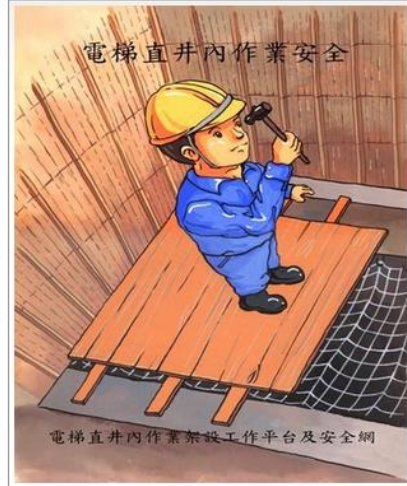
雇主應設置施工平台等適當之防護設備，以防止墜落災害發生。
