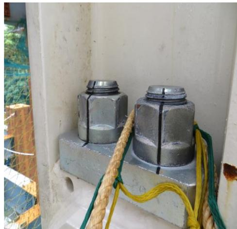
圖 3-31 鎖固螺栓並劃線
