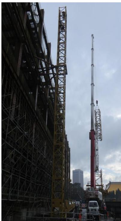
圖 3-29 塔節支撐與高度限制
