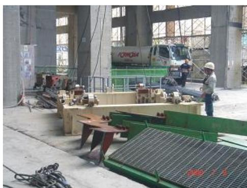
圖 3-27 塔吊基礎拆除
