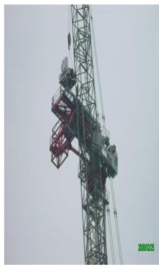
圖 3-9、10、11 組裝 1/3 配重塊、A 架組裝、動力（捲揚、俯仰）機組組裝
