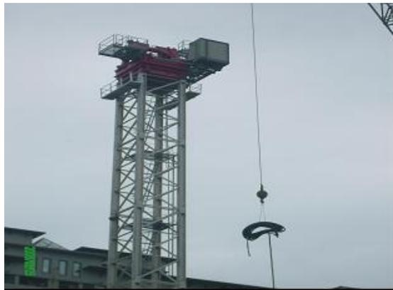
圖 3-7 塔節（含標準塔節、爬升塔節）
