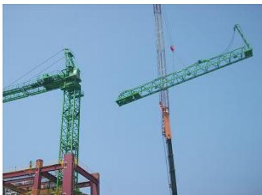
圖 3-19 前桁架拆除
