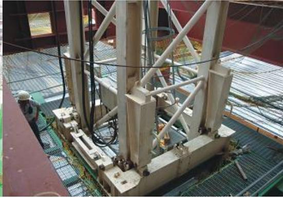
圖 3-5 塔吊基礎安裝（座夾樑安裝）
