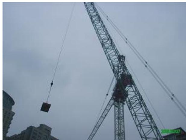
圖 3-15 組裝 2/3 配重塊及全部配重塊與結構繫固
