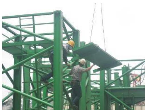
圖 3-26 座夾樑平台拆除
