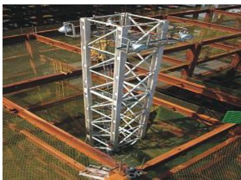
圖 3-25 塔節拆除
