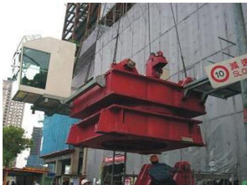
圖 3-23 旋轉機組及機械平台拆除
