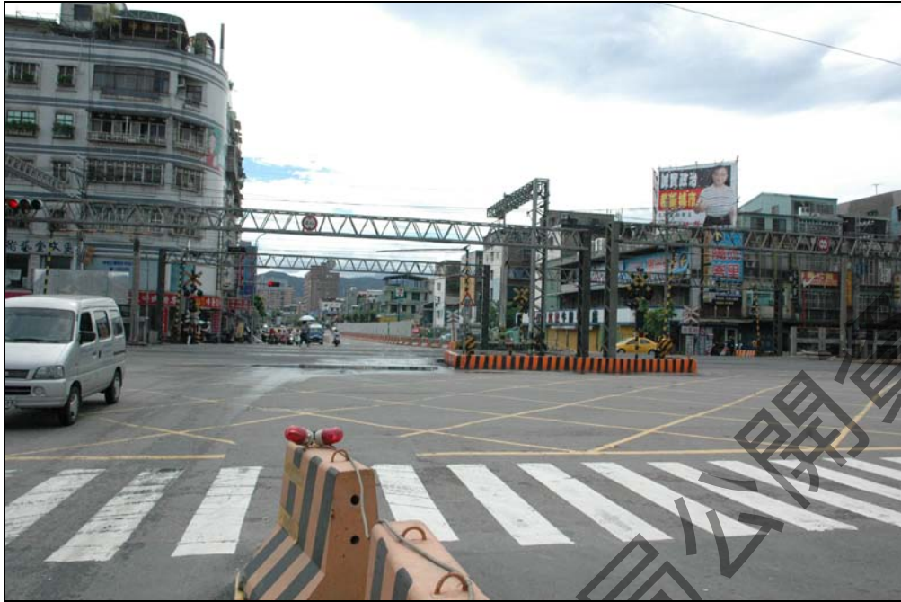
圖 6.3.2.8-2 樹林市八德路地下道施工現況
