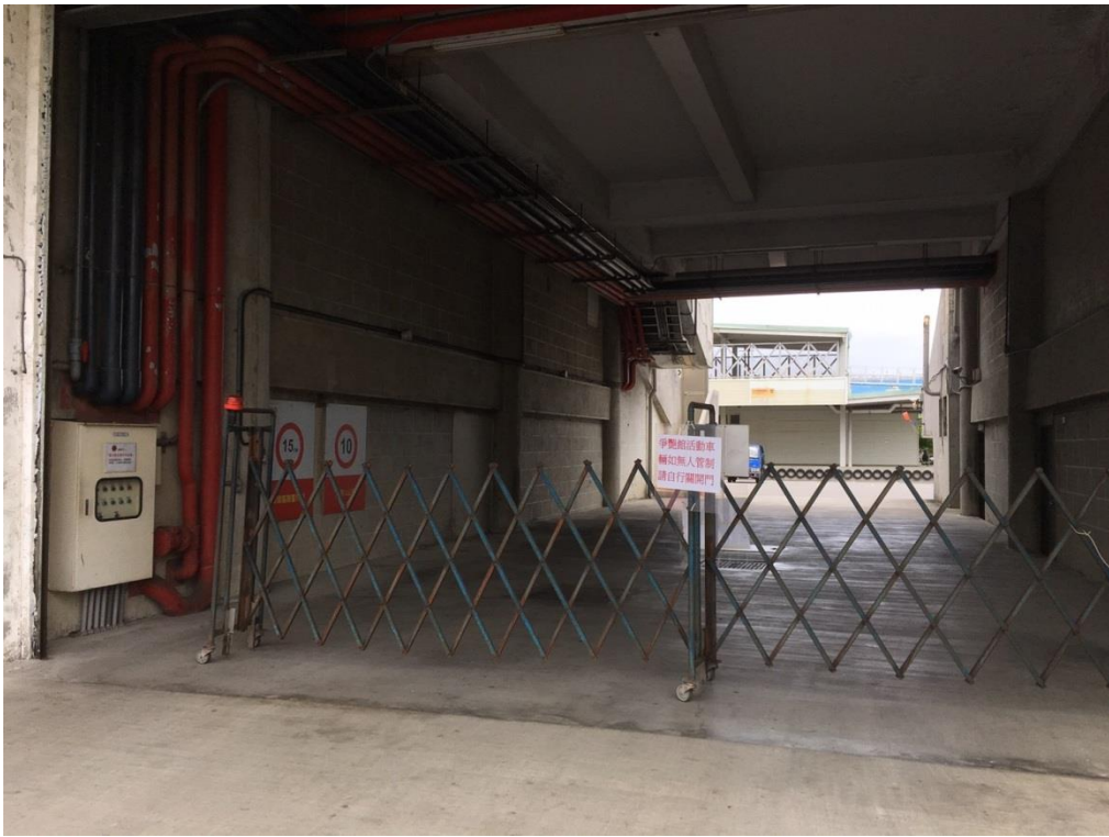
爭艷館卸貨區的管制通道
