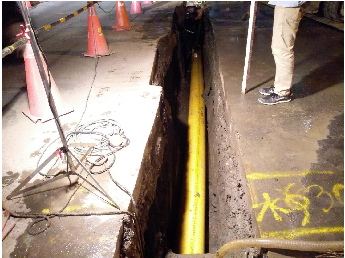
圖 十七 大臺北瓦斯查修管線
