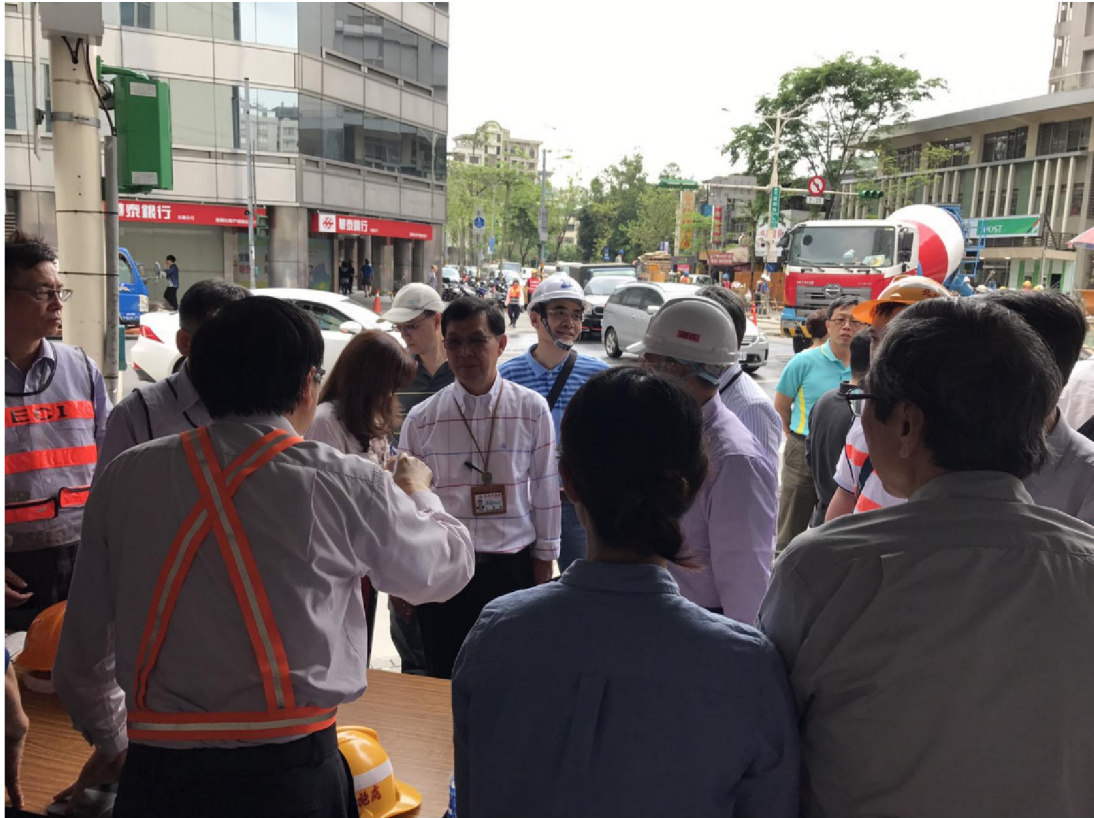
圖 十三 工務局彭局長巡視現場
