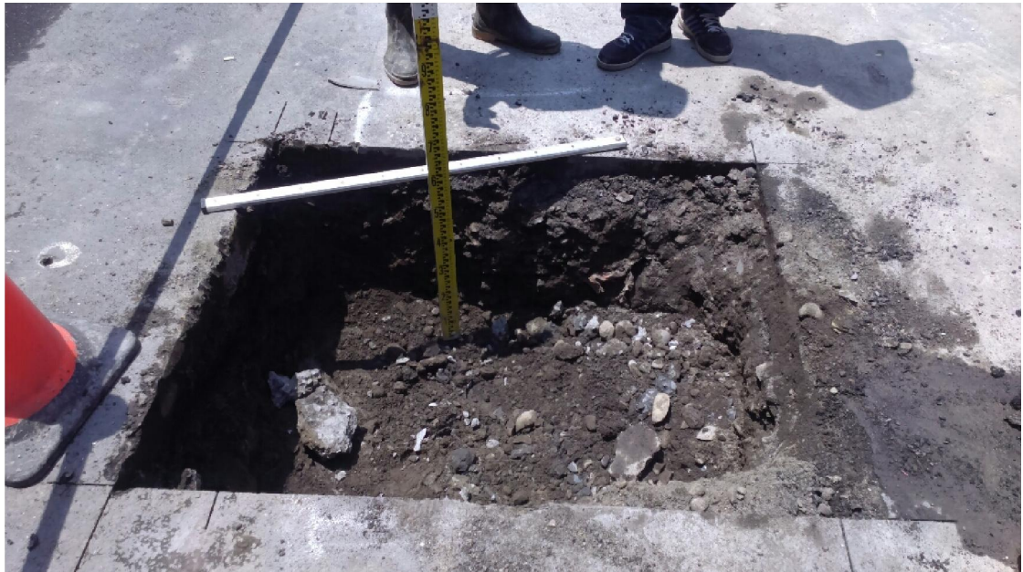
圖 十八 自來水處查修管線
