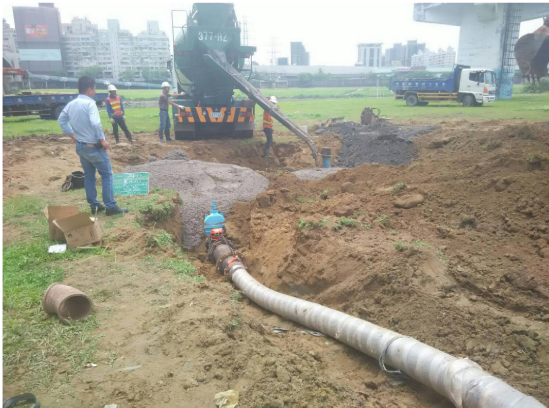
圖 十 安裝注水管
