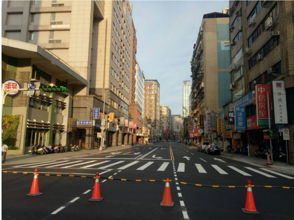
圖 十九 標線全數完成
