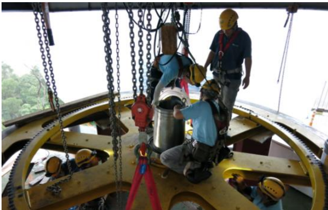
照片 7 106 年貓空纜車年度檢修作業
