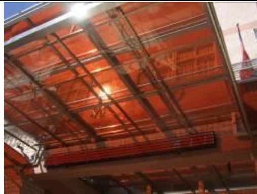
圖二：大門穿堂非晶矽太陽能板共 4.08kWp
