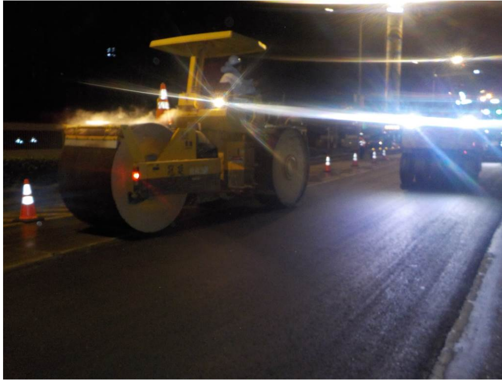
內側 2 車道新拌改質Ⅲ型瀝青混凝土面層滾壓
