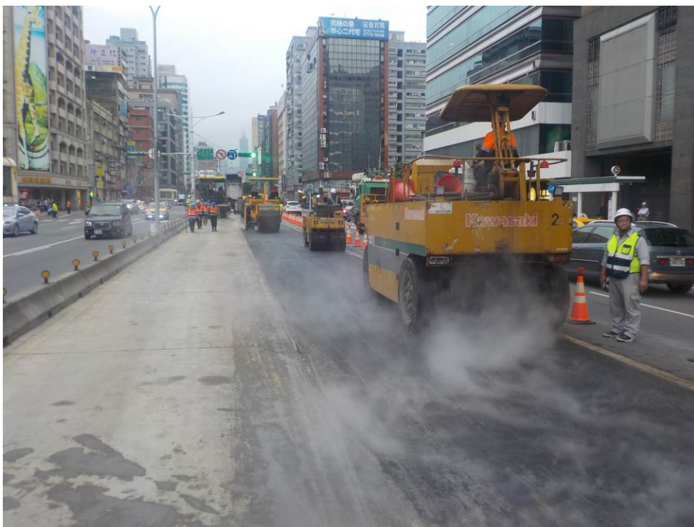
回填範圍再生瀝青混凝土面層滾壓
