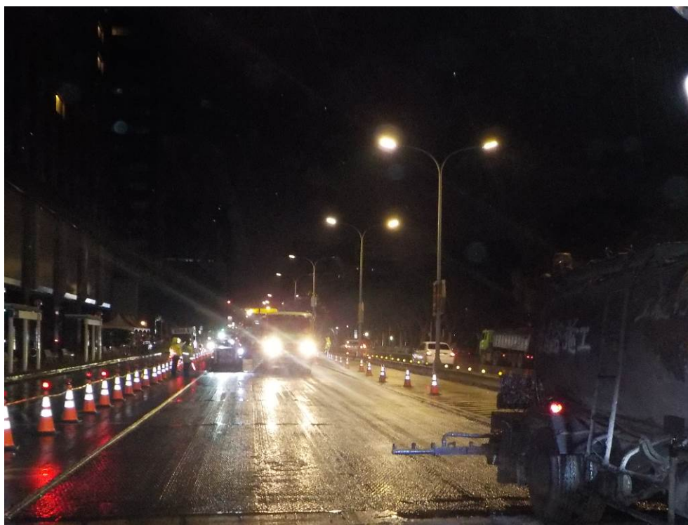
內側 2 車道黏層撒佈
