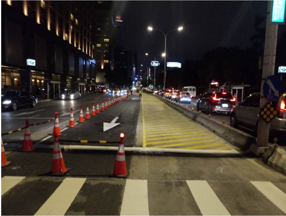
回填範圍再生瀝青混凝土養護並劃設臨時標線
