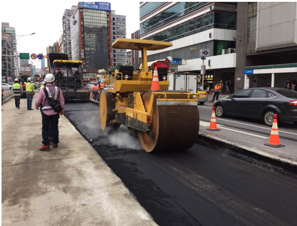
回填範圍再生瀝青混凝土底層滾壓
