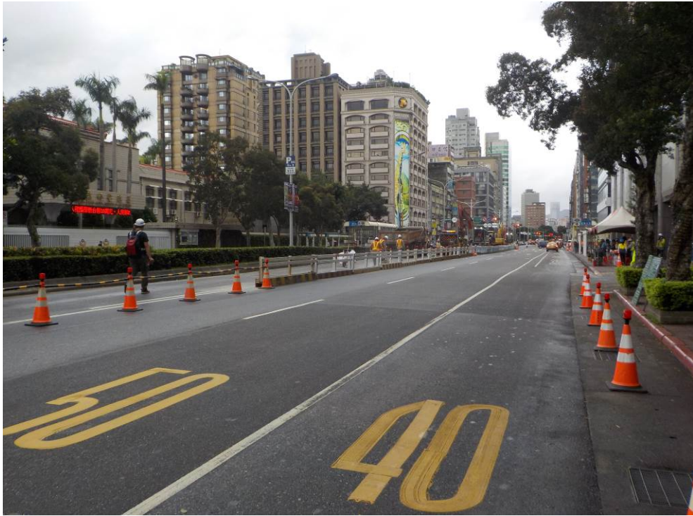
型鋼護欄及交通錐連桿佈設
