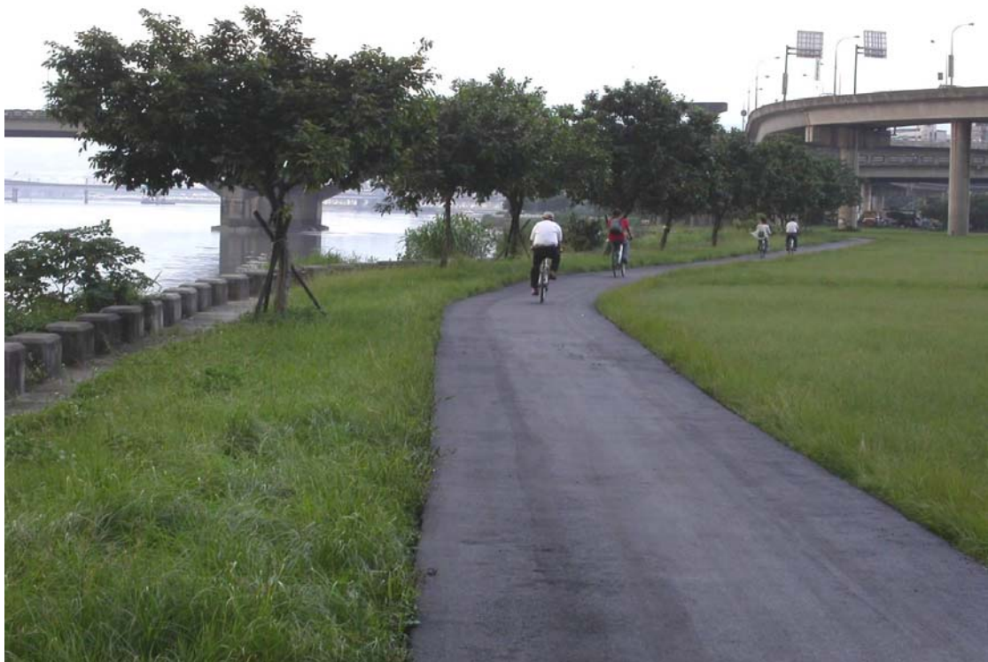
照片十三、本(九十三)年度施工中(路面尚未劃設標誌)河濱腳踏車道—淡水河右岸忠孝橋附近
