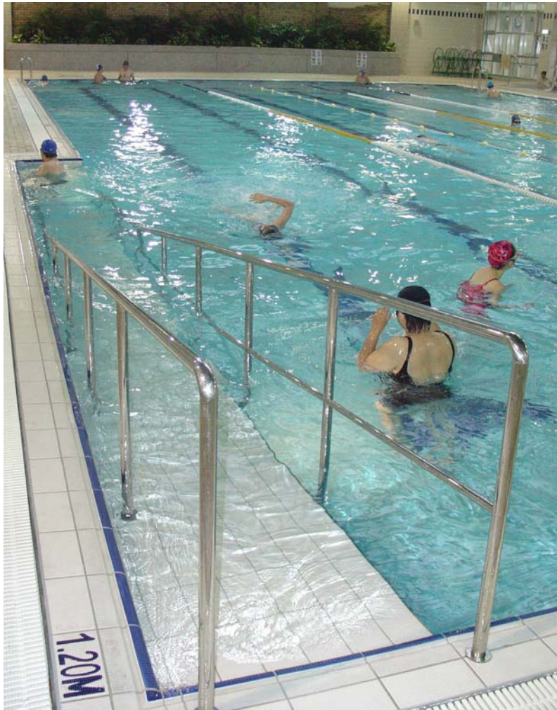
照片二十二、迪化運動公園溫水游泳池—無障礙入水坡道
