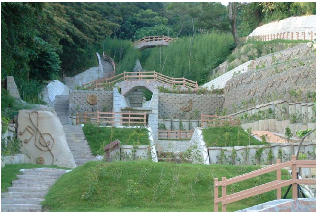
照片三十三、北安路五〇一巷危險聚落拆除後，水土保持整治完成
