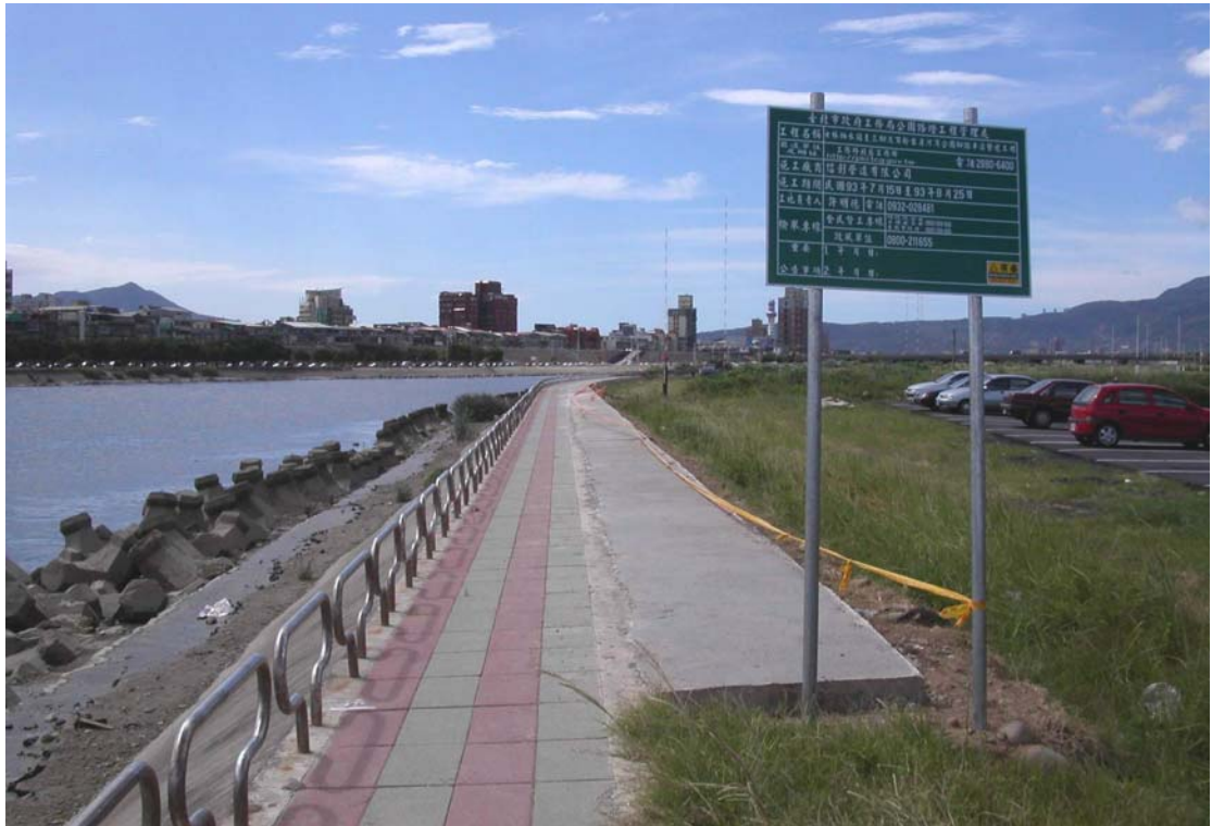
照片十二、本(九十三)年度施工中河濱腳踏車道—基隆河右岸百齡橋附近
