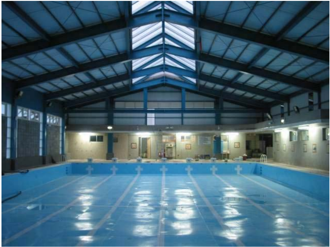
照片二十、吉林國小溫水游泳池
