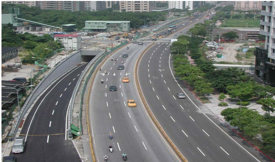
照片五、93.6「北二高臺北聯絡線信義支線」信義路車行地下道施作完成，全線預定於 94.3 通車。
