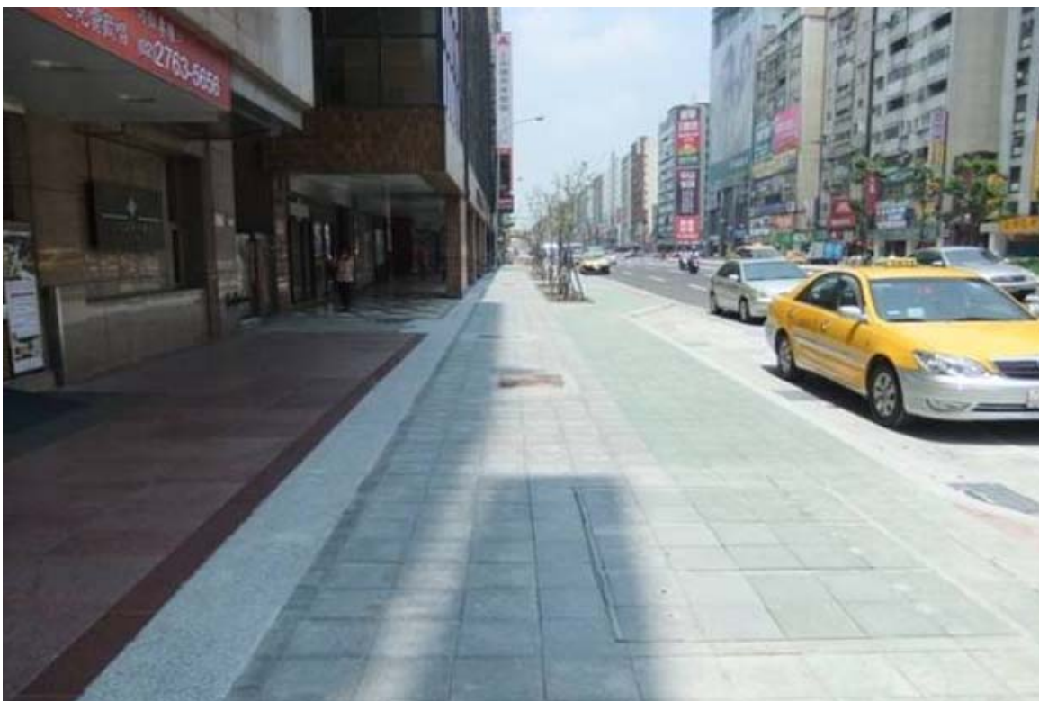
照片 4、松山線南京東路 5 段人行道復舊
