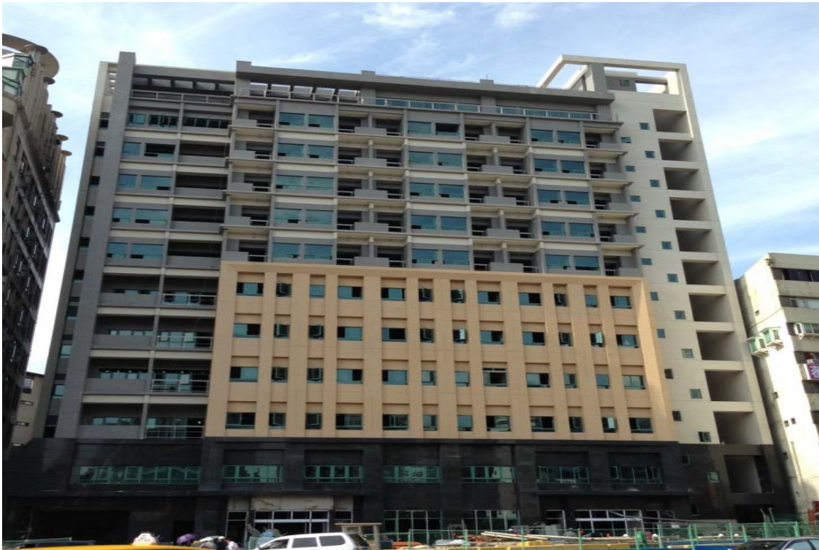
照片 17、臺北市北投觀光醫療暨健康保健中心大樓施工現況
