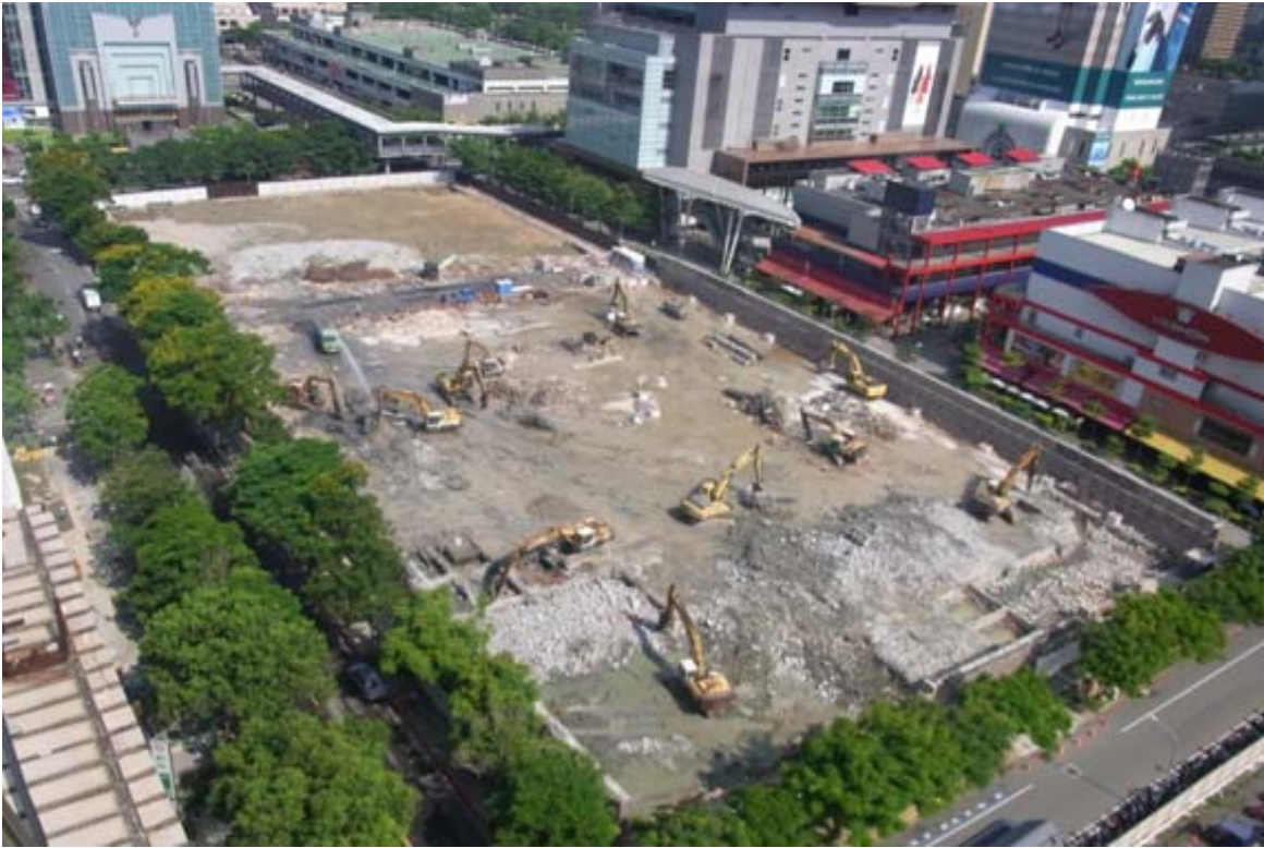
照片 1、102 年 6 月「臺北城市綠丘」地上舊有建築物已拆除完竣
