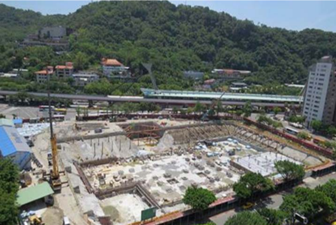
照片 18、「臺北藝術中心」102 年 8 月工地現況
