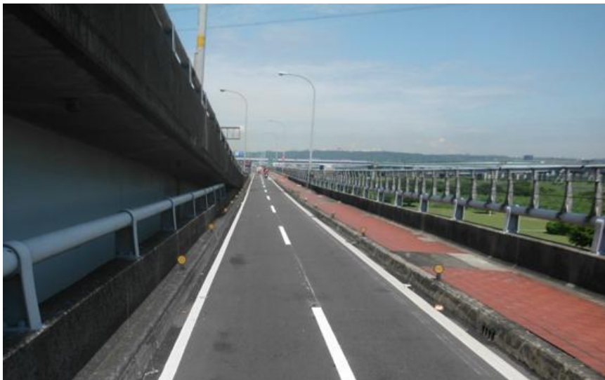
華江橋機車道增繪車道線
