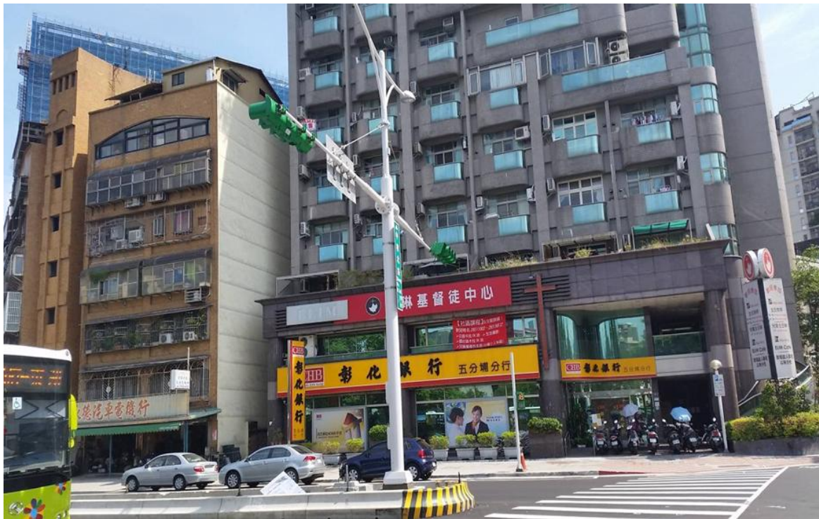
中坡北路、松山路 119 巷路口號誌路燈共桿(施工後)
