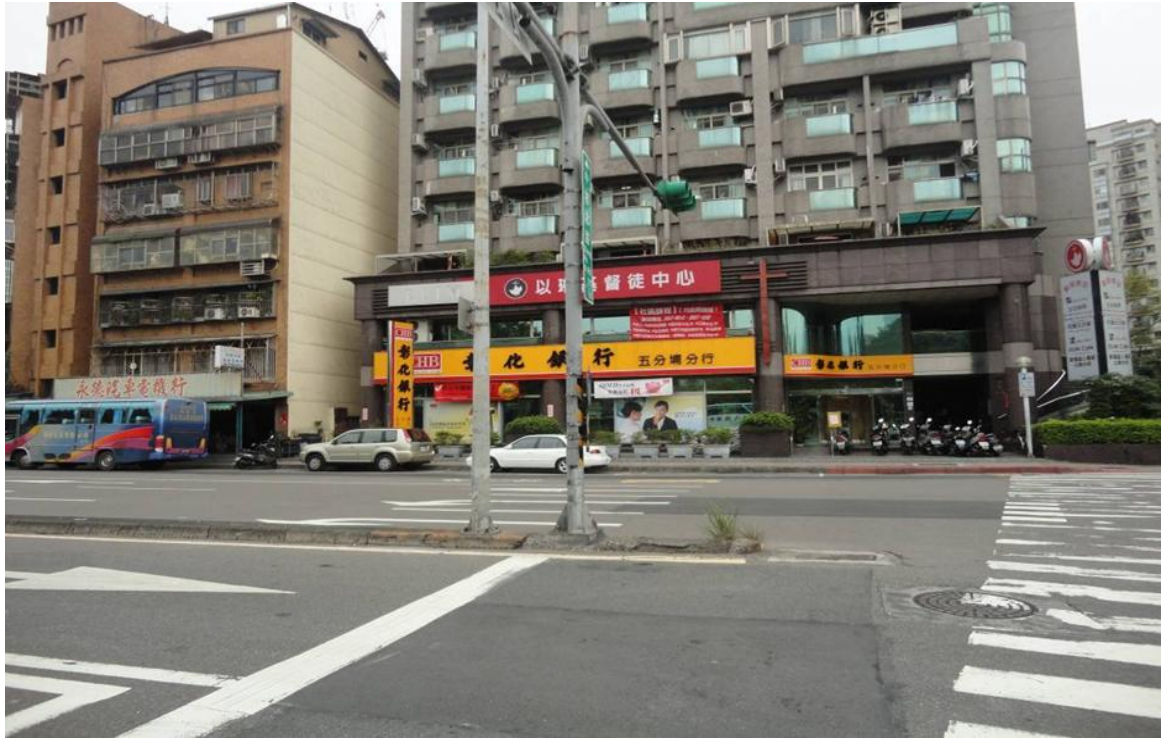
中坡北路、松山路 119 巷路口號誌路燈共桿(施工前)
