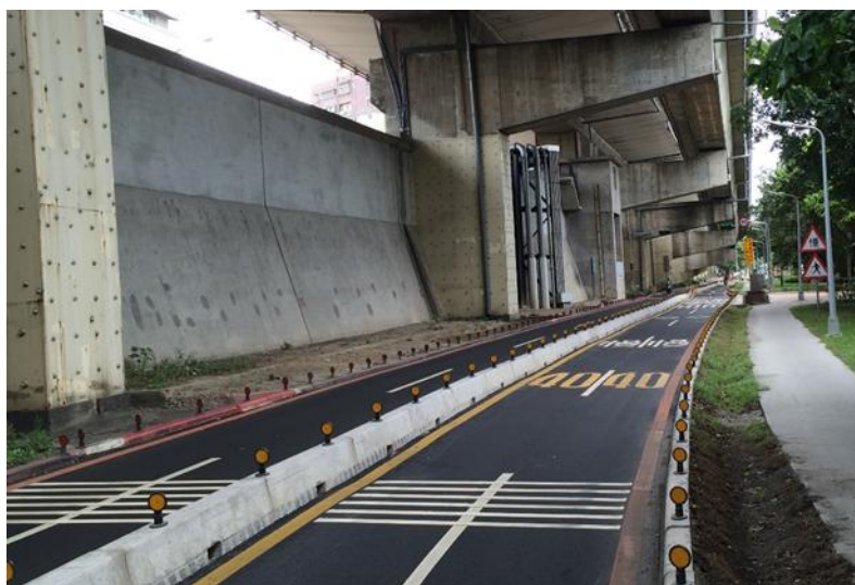
桂林路堤外機車便道
