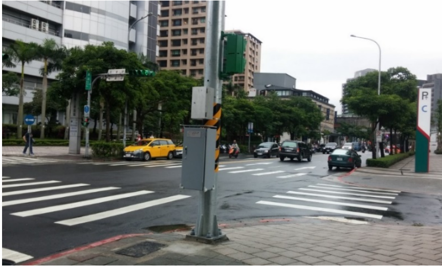
圖 13 三重路經貿二路 106 巷口號誌控制器縮小化
