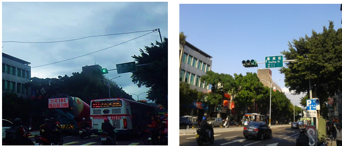
圖 14 中正路華興街口號誌纜線下地前後照片
