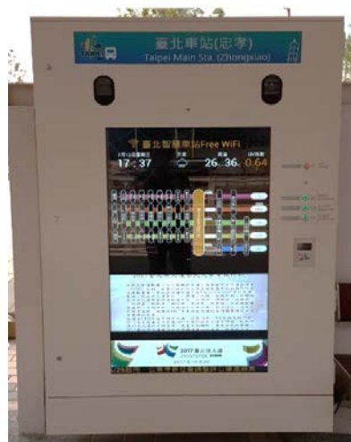
圖 12 臺北車站交 6 站區 4G 候車亭
