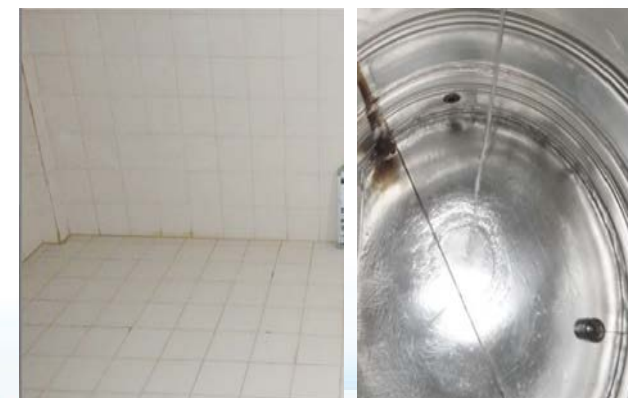
清洗水池水塔
