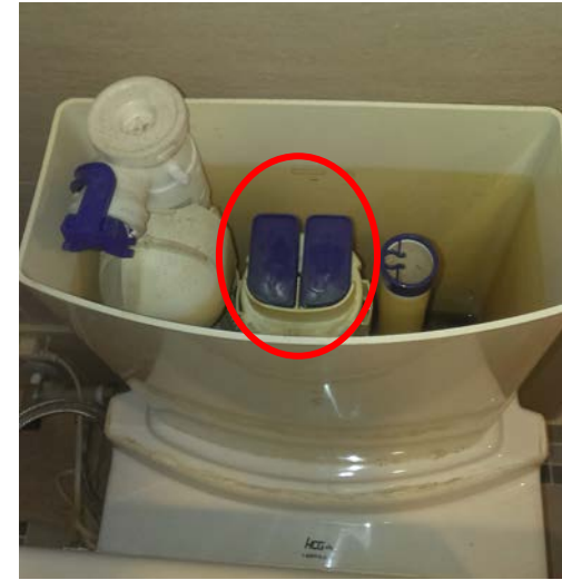
沖水鈕按壓卡住水箱進水直瀉而流
