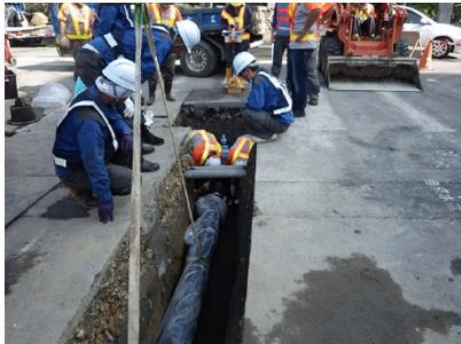
圖 5 引進日本 NS 型管選址、現場指導之施工過程
