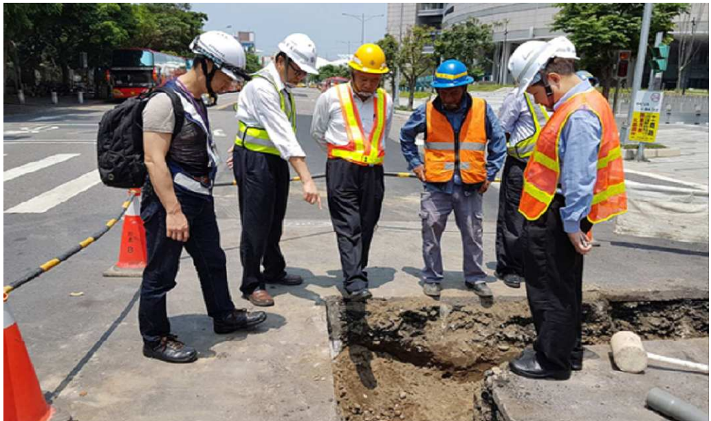
照片 8：會同台電進行作業現場查核
