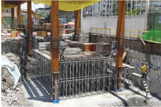
南門市場現場施工照片
