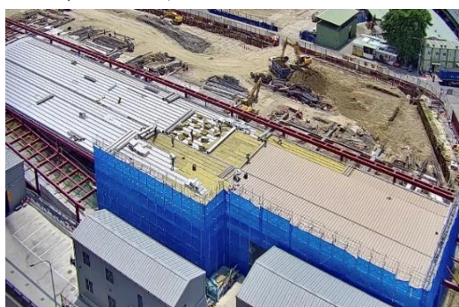
農中繼南側施工現況
