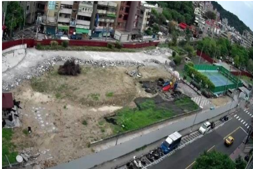
南門市場現場施工照片
