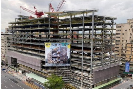
南門市場現場施工照片
