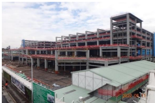
環南市場第二期工程現況
