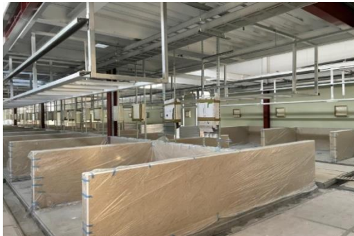
北投中繼市場現場施工照片
