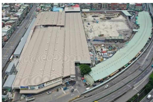
主體工程施工現況
