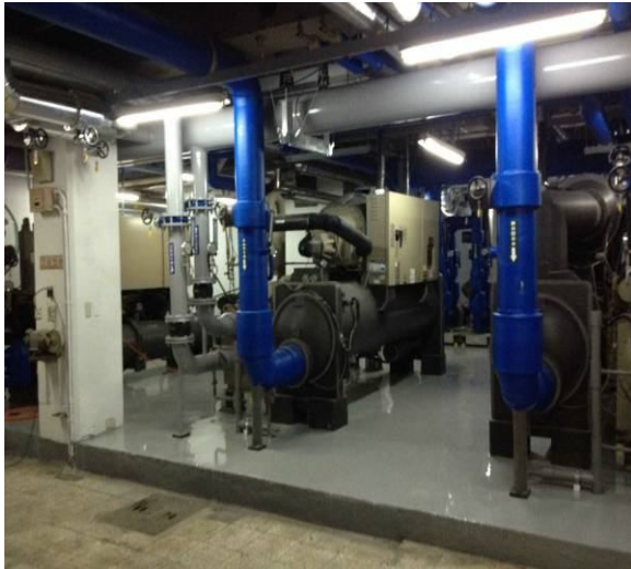
補助業者換裝節能螺旋式冰水主機
