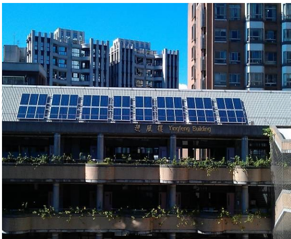
南港國小設置太陽光電發電系統
