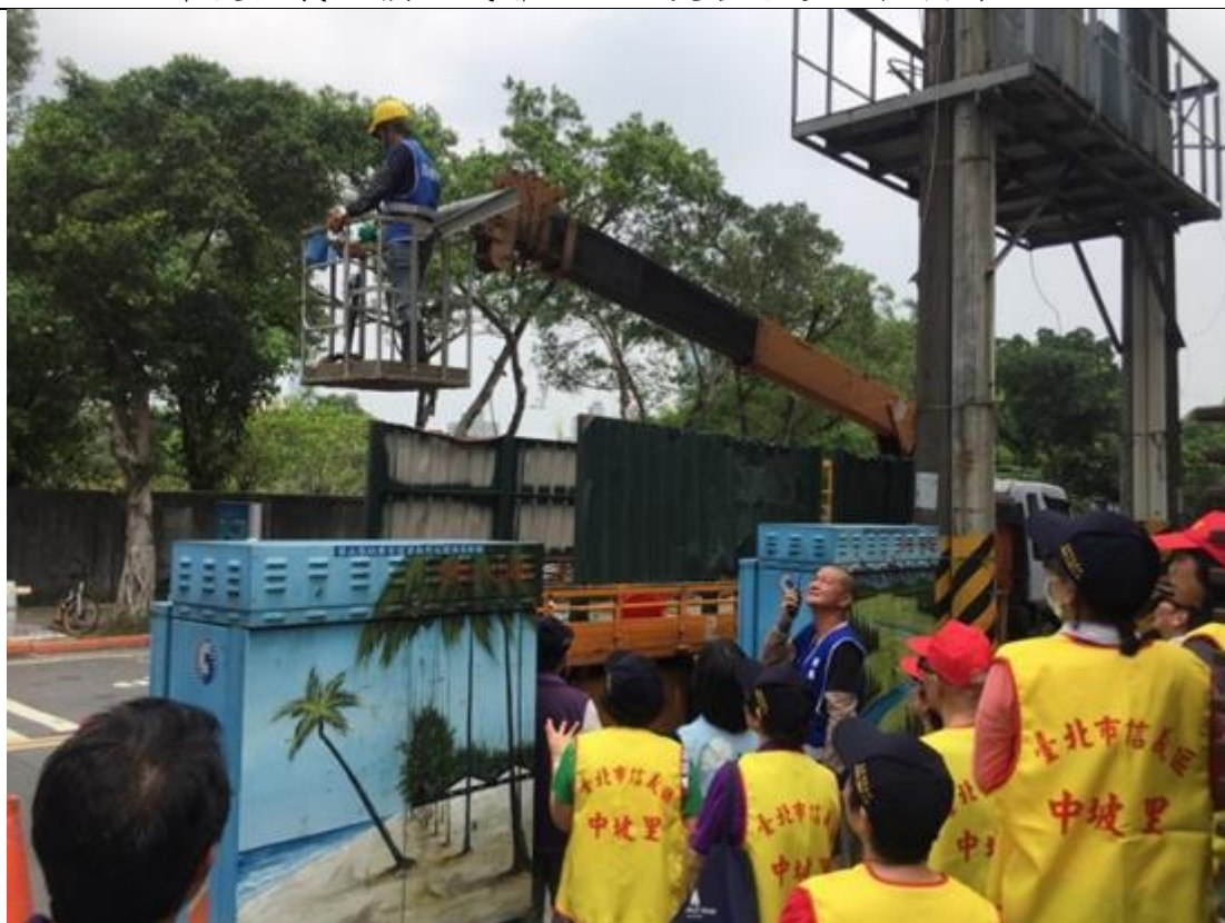
說明：107年度信義區預約式鄰里天然災害搶修工程演習
