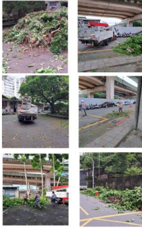
台北機廠(總動機廠)111年11月2日~4日喬木修剪施作照片紀錄 喬木修剪施工後
