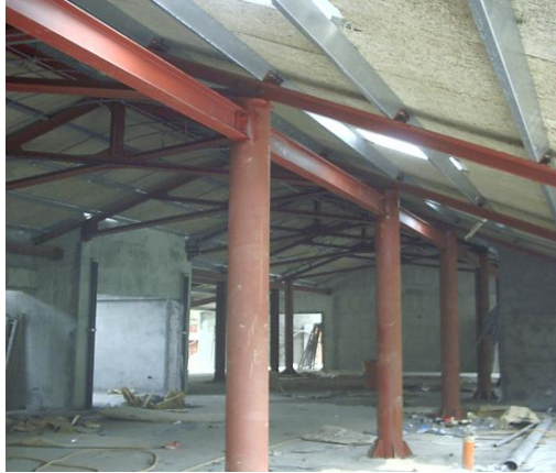
圖 33 眷舍建築鋼架主體結構
