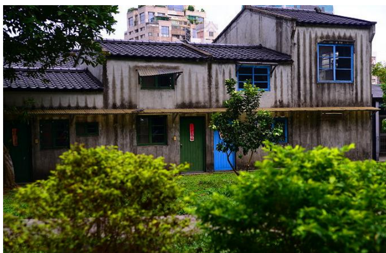
圖 15 拆除前的南村二樓增建部分
