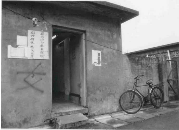
圖 20 四四南村公共女廁所
