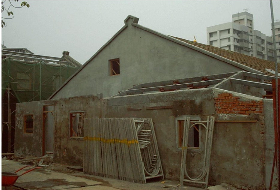
圖 32 公民會館屋頂與外牆的修復 資料來源：臺北市信義區公所提供
