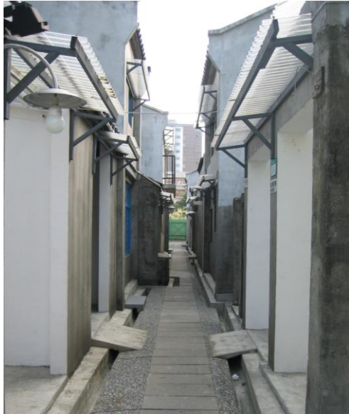
圖 35 戶外雨遮及附屬物件之修復 資料來源：臺北市信義區公所提供
