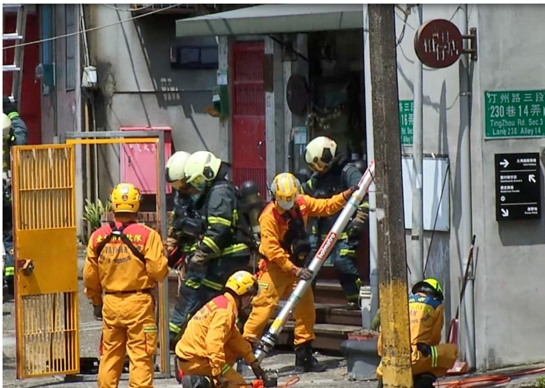
照片說明：搜救人員進入倒塌建物搶救受困者。
