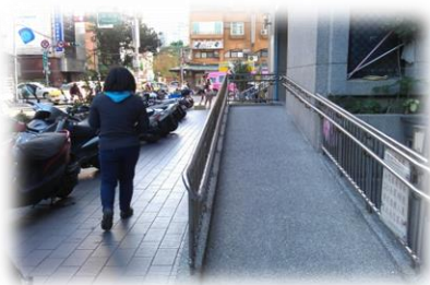
無障礙斜坡道
