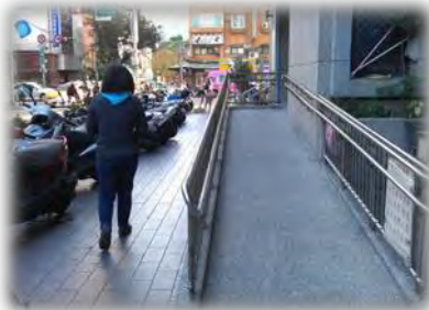
無障礙斜坡道
