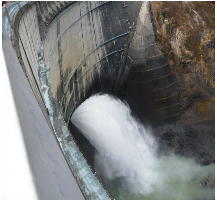
【圖 42 壩頂洩水口調節水量，高度 186 公尺】
