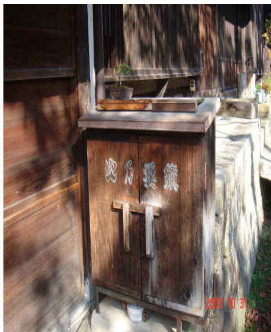
【附圖 30 消防器材儲存處所仍維持舊時外觀】
