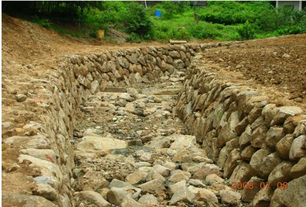
照片 4 登山路溪溝整治工程 - 主流砌塊石護岸
