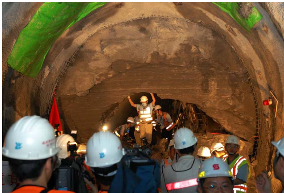
照片 1 97.7.16 自來水處第 2 原水管隧道貫通
