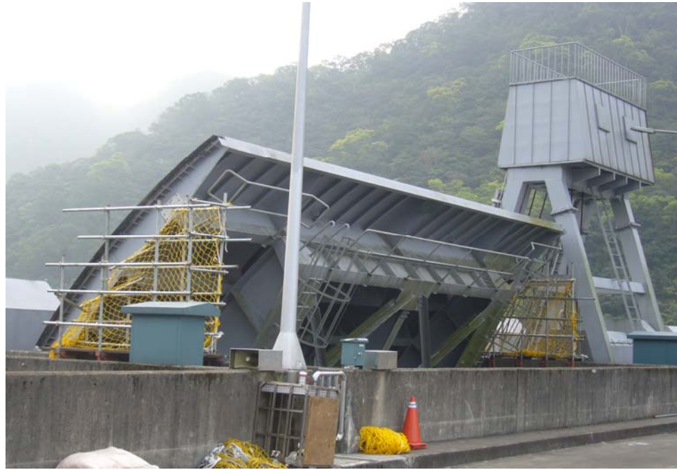
照片 2 97.3.17 大壩溢洪道弧型閘門改善
