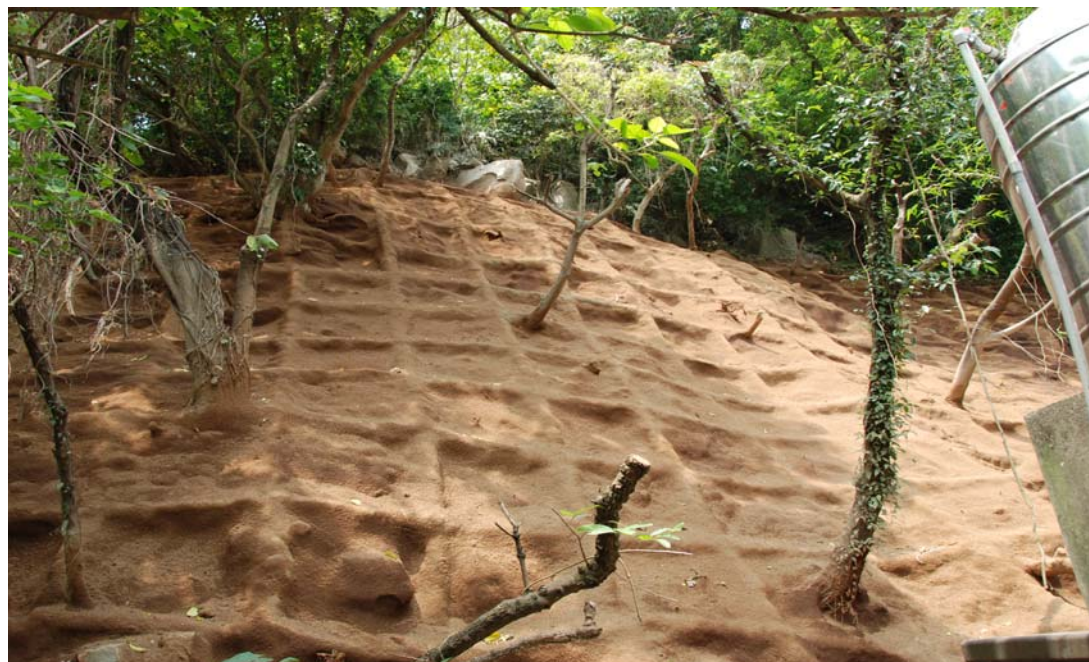
照片 2 中山區通北街 118 巷老舊聚落減災處理
