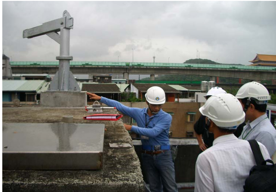
照片 2 大樓外牆清潔作業安全宣導示範設備
