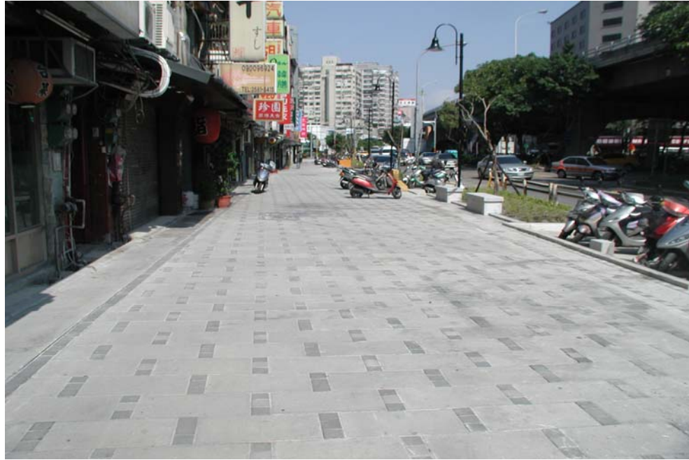
照片 1 七條通街區道路改善工程
