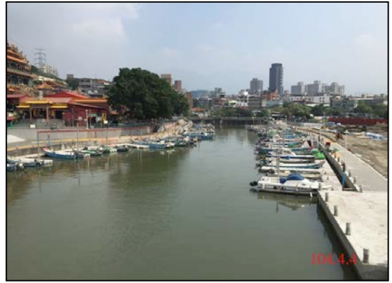
中港河碼頭及周邊環境改造工程
