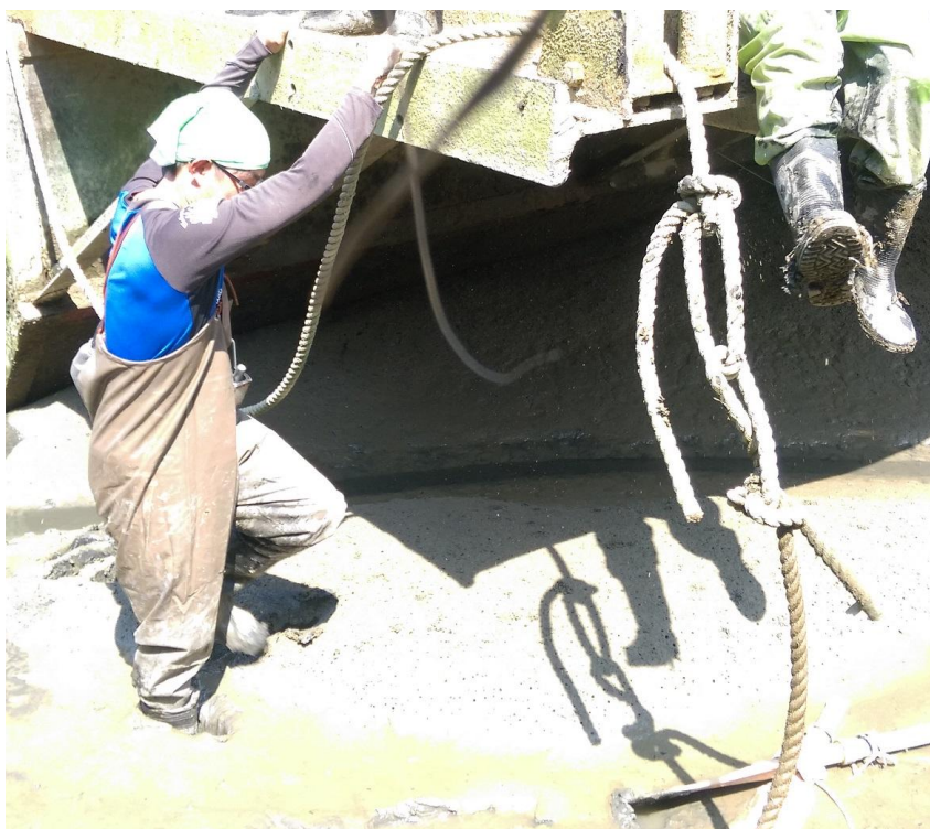
圖 3.7 嘗試以抽砂船為跳板跨越槽溝
