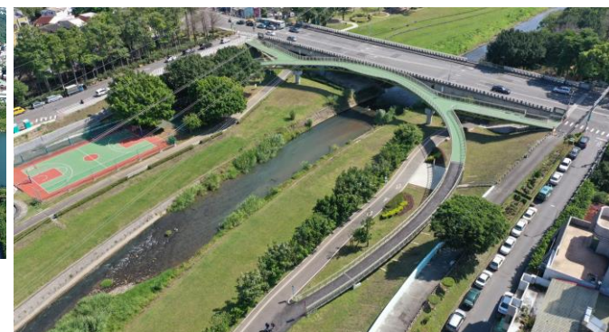
復興橋西側人行景觀橋暨自行車牽引道
