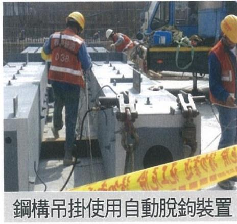
鋼構吊掛使用自動脫鉤裝置
