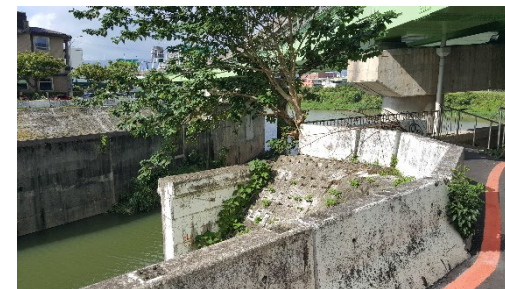
6. 大坑溪右岸護坡現況
