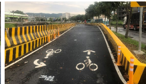
4. 大坑溪左岸堤頂自行車道
