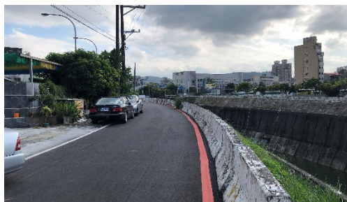
5. 大坑溪右岸堤頂現況
