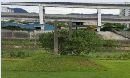
4. 右岸高灘地葫蘆洲吊橋橋塔(歷史建物)
