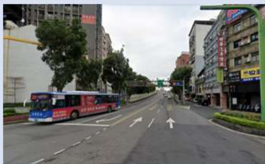
4. 中興橋引道(接康定路)現況
