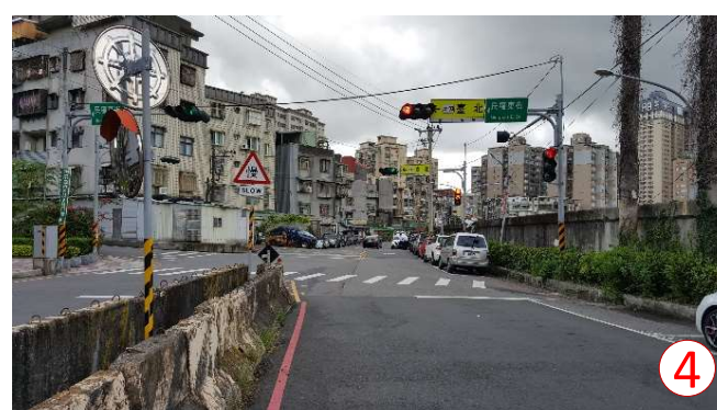
左岸防汛道路及防洪牆
